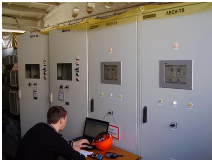
Рис. 4.27.3 – Наладка системы выделения станций на сбалансированный энергорайон на Омской ТЭЦ-4.
